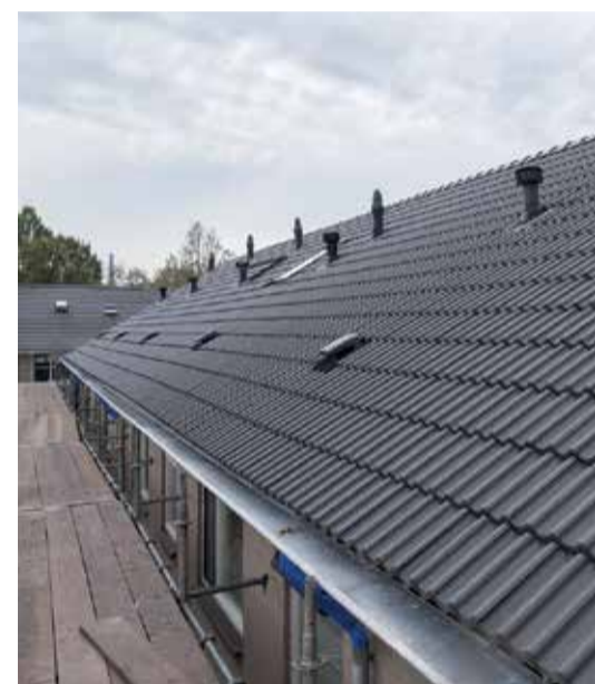
▲ Na drie dagen werken op het dak liggen de nieuwe pannen erop.
