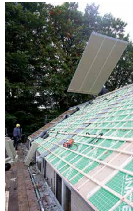
▲ Met vier hijsbewegingen per woning ligt het nieuwe dak erop.
