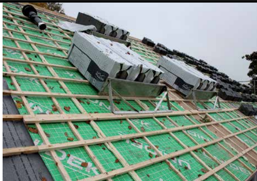
▲ De dakpannen worden in pakketten op bokken op het dak gezet.
