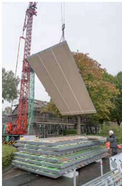
▲ Voor de woningrenovatie worden onder meer acht dakelementen per dag aangevoerd.
