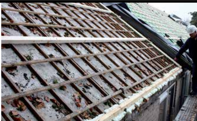
▲ Voor het plaatsen van de nieuwe dakelementen is op het bestaande dak eerst nauwkeurig een aanslaglat aangebracht.
