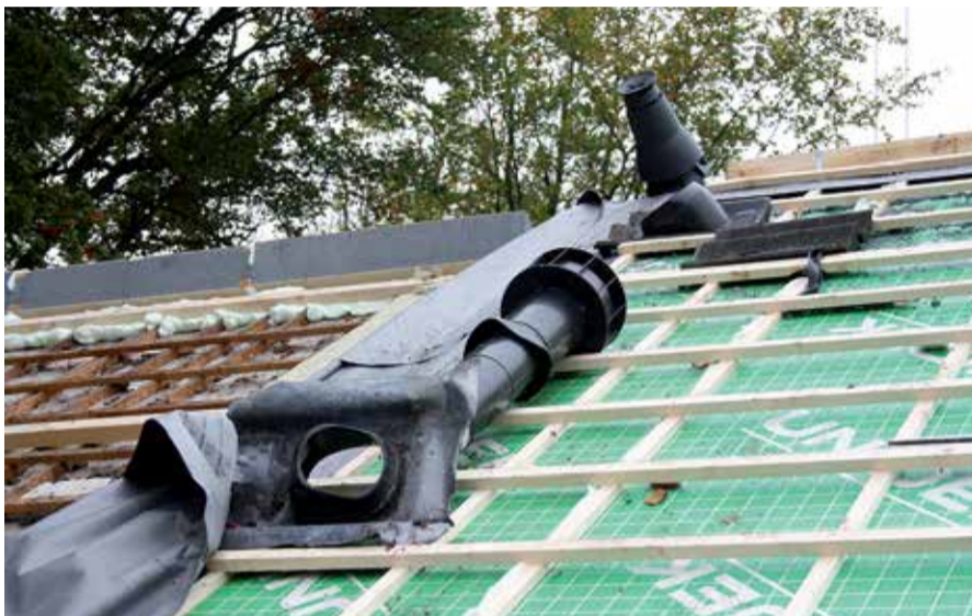
▲ Doorvoeren voor ventilatiepijpen en dergelijke worden eveneens ter plekke ingezaagd.
