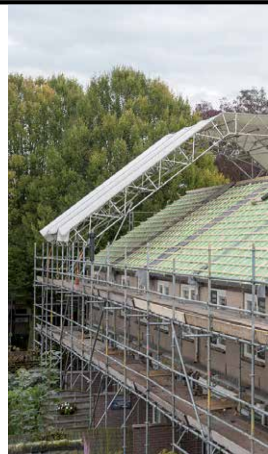
▲ Voor het plaatsen van de nieuwe dakelementen is op het bestaande dak eerst nauwkeurig een aanslaglat aangebracht.
