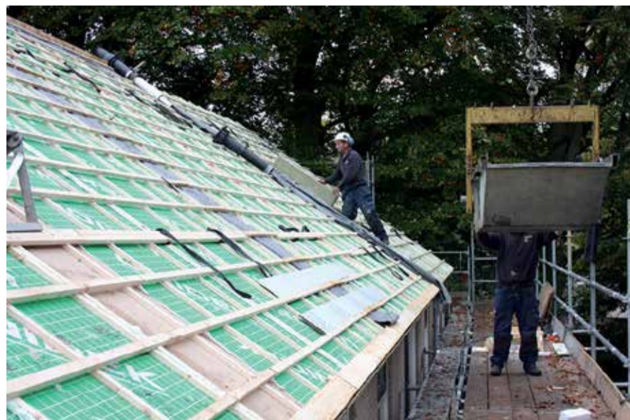
▲ Overtollig verpakkingsmateriaal en overige rommel wordt zo snel mogelijk van de werkplek verwijderd.
