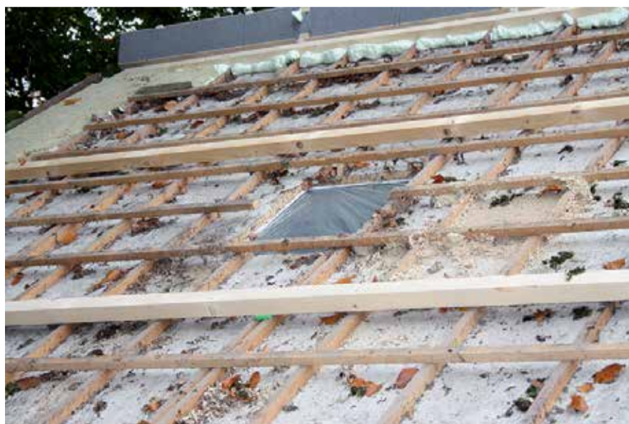
▲ De ramen zijn verwijderd; in de nieuwe dakelementen worden ze ter4 plaatse uitgezaagd.
