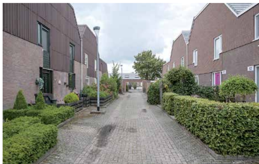
▲ Met het vervangen van de golfplaten in de gevel (links) door metselwerk en nieuwe dakranden wordt de bijzondere vorm van de daken benadrukt.
