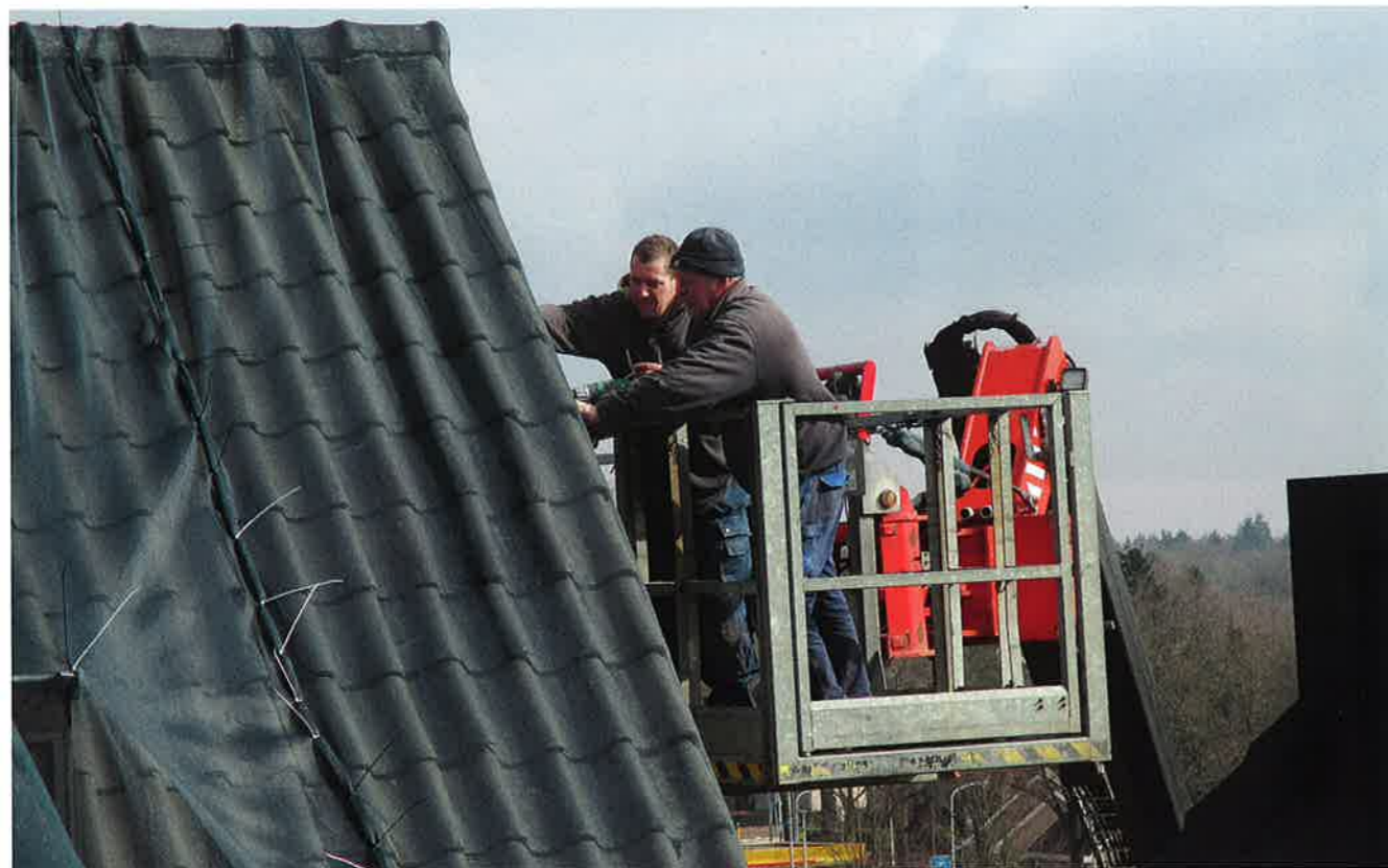
Netten over het hele dakvlak, van nok tot goot, dienen om te voorkomen dat vogels terugkomen op de plaats waar de dakrenovatie moet plaatsvinden.
